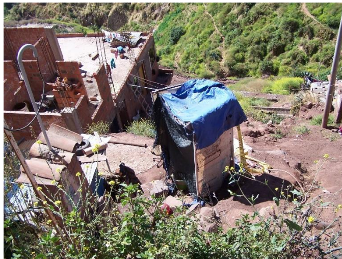
Imagen N° 60: Pozo seco ubicado en medio de la vía proyectada
