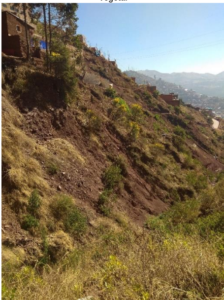
Imagen N° 27: Deslizamientos de tierra en zona de estudio disminuyendo la densidad de la cobertura vegetal
