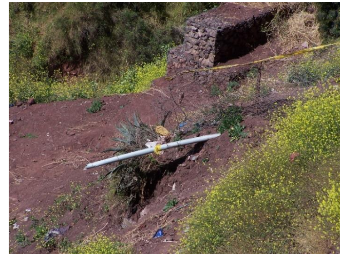
Imagen N° 62: Tubería de desagüe vertiendo aguas en la quebrada
