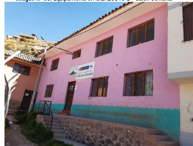
Imagen N° 50: Equipamiento en la ZRECU10-B - Salón Comunal
